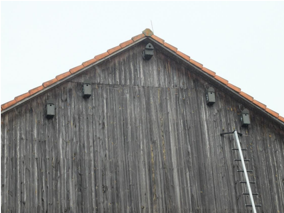
Abbildung 8: An der Ostwand der Scheune wurde neuer "Wohnraum" geschaffen (Foto: B. Querfurth)
