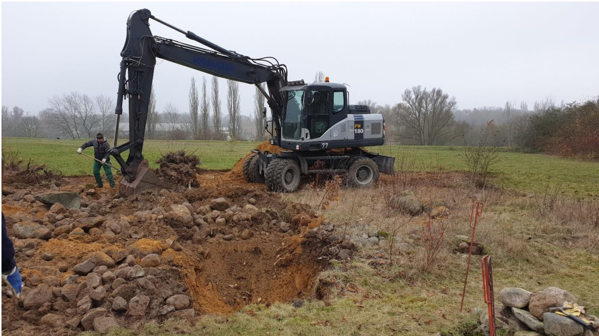
Abb. 3: Arbeiten am GF1 (25. November 2019)
