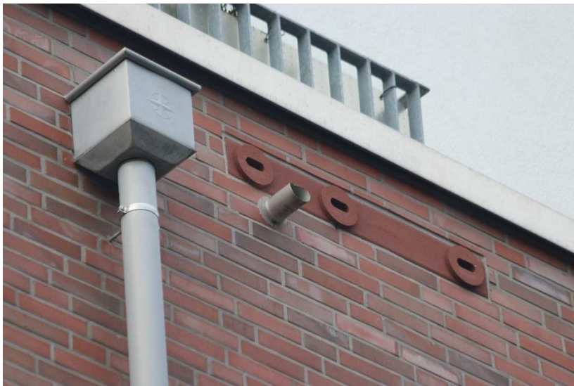
Abbildung 4: Anflug mit Hindernissen; warum wurden die Kästen nicht zwei Meter weiter rechts montiert!?
